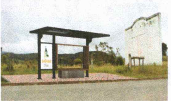
CONSTRUCCIÓN DE PARADAS DE BUS
