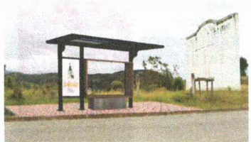
CONSTRUCCIÓN DE PARADAS DE BUS
