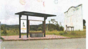
CONSTRUCCIÓN DE PARADAS DE BUS
