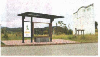
CONSTRUCCIÓN DE PARADAS DE BUS
