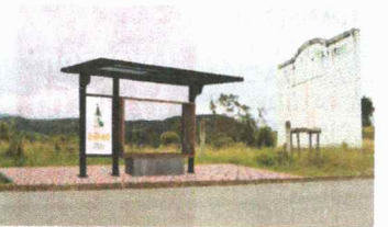
CONSTRUCCIÓN DE PARADAS DE BUS
