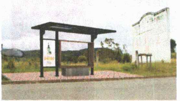
CONSTRUCCIÓN DE PARADAS DE BUS
